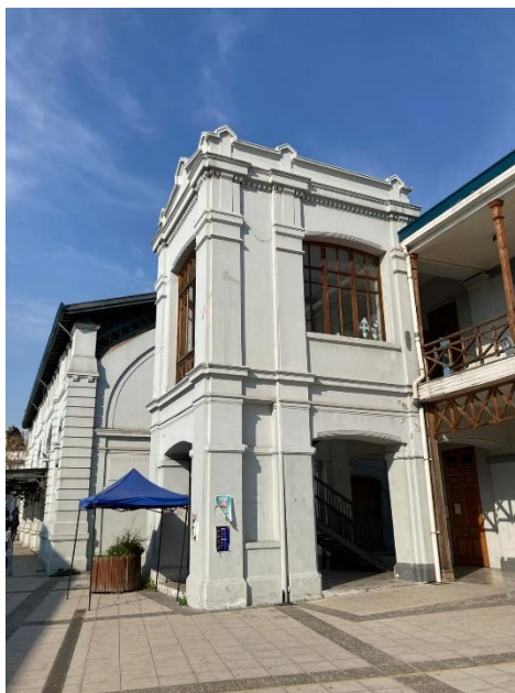
Imagen 2: Patio interior del Liceo de Aplicación, Santiago (Chile). Fuente: repositorio personal.
