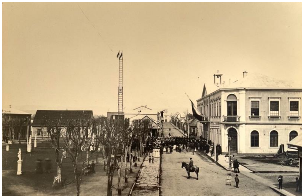
Imagen 7: Fotografía de la Plaza de la República e Intendencia de Valdivia (1896). Fuente: Archivo Fotográfico, Centro Cultural El Austral, Valdivia.
