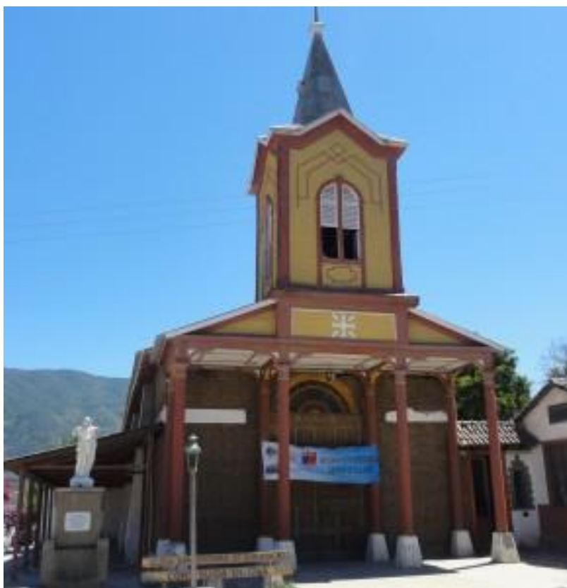
Figura 2. Fachada del templo de Alhué. Fuente: Disponible en https://municipalidadalhue.cl/portal/a-pasos-agigantados-avanza-restauracion-de-parroquia-san-jeronimo/ .
